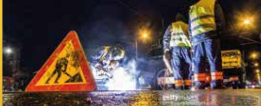
Heraanleg N3 Gordaallaan en Coigesteenweg (p. 2)
